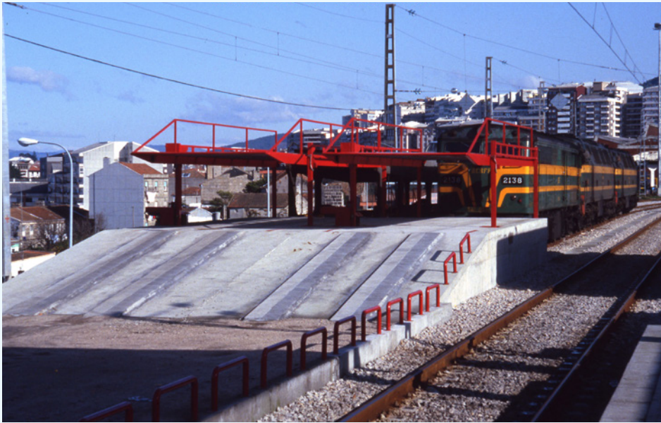
Foto izq. Instalación con inclinación de parte superior para la carga de automóviles (Vigo. Foto: Carlos M.Barreiro Molinos. Fuente: Asociación Viguesa de Amigos del Ferrocarril y Tranvías -AVAFT Rías Baixas -)
