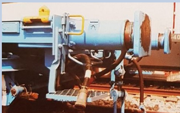
Mangueras de intercomunicación para sistema informático, instaladas en una plataforma MMC3e / Sgnss del 2º lote (Sevilla-La Negrilla, Junio 2003. Foto: Juan José Romero Rioja. Fuente: revista Maquetren nº125)
